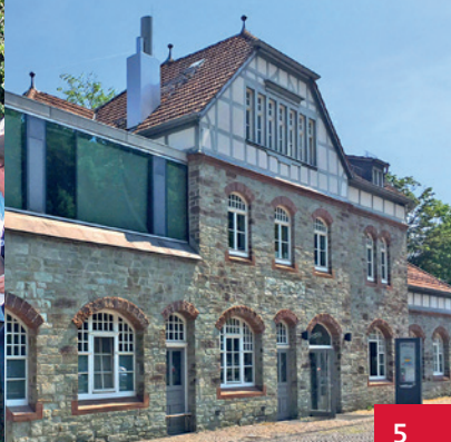
Bahnhof Eppstein, Foto: Burgmuseum
