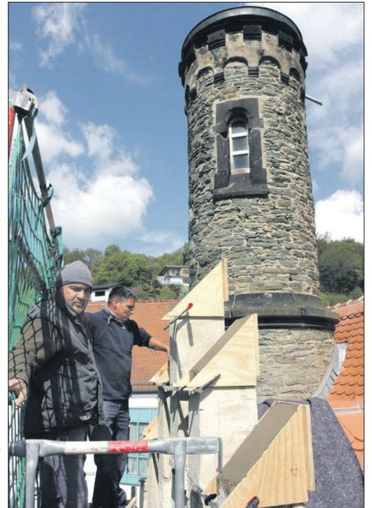
Ismet Karakaya und Peer Wernecke betonierten die Widerlager für die auskragenden Platten aus grauer Basaltlava. Foto: Palmert-Adorff
